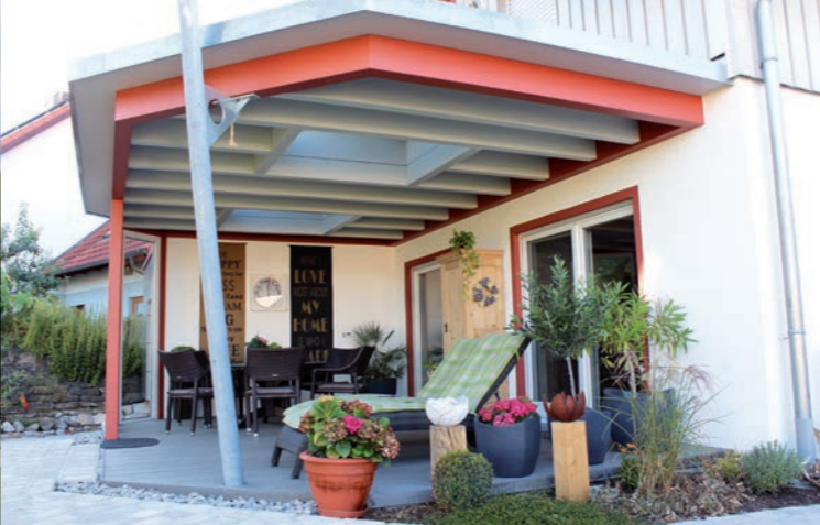
Terrassenüberdachung als Flachdach
